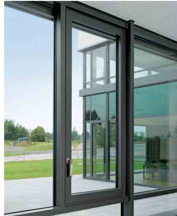
Sebia Bürogebäude, Fulda, Deutschland Sebia office buildings, Fulda, Germany
